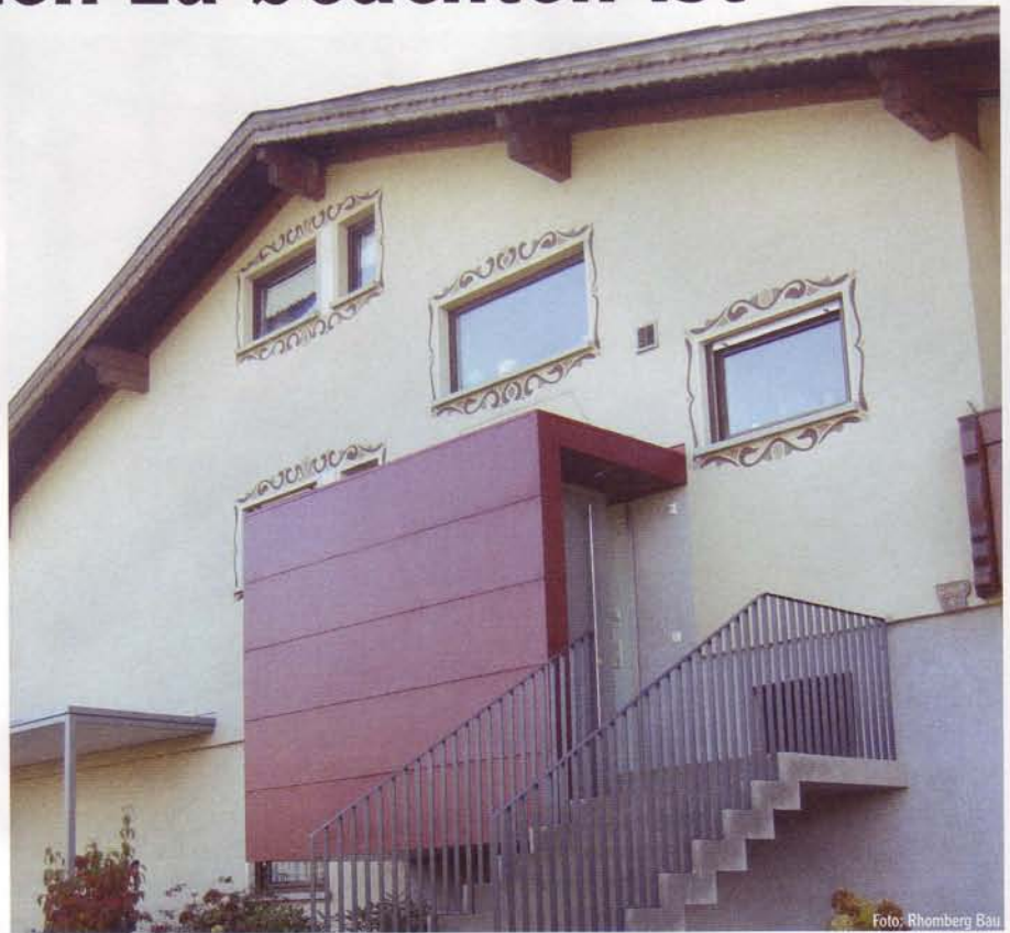
Foto: Rhombert Bau
